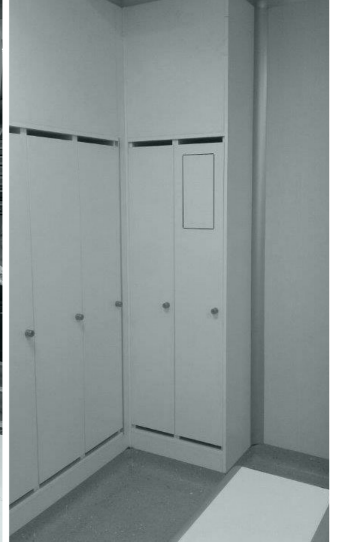
Armadio con ante a battente e botola sporco/pulito / Cabinet with hinged doors and dirty/clean hatch / Armoire avec vantaux de porte battantes et trappe sale/propre
