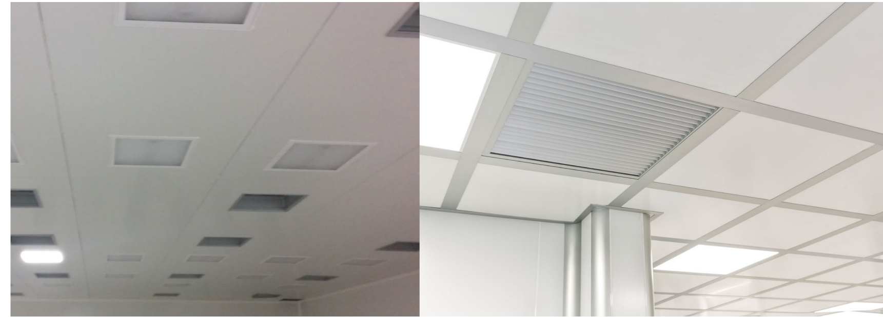
Controsoffitto calpestabile Walkable false ceiling Faux-plafond praticable
